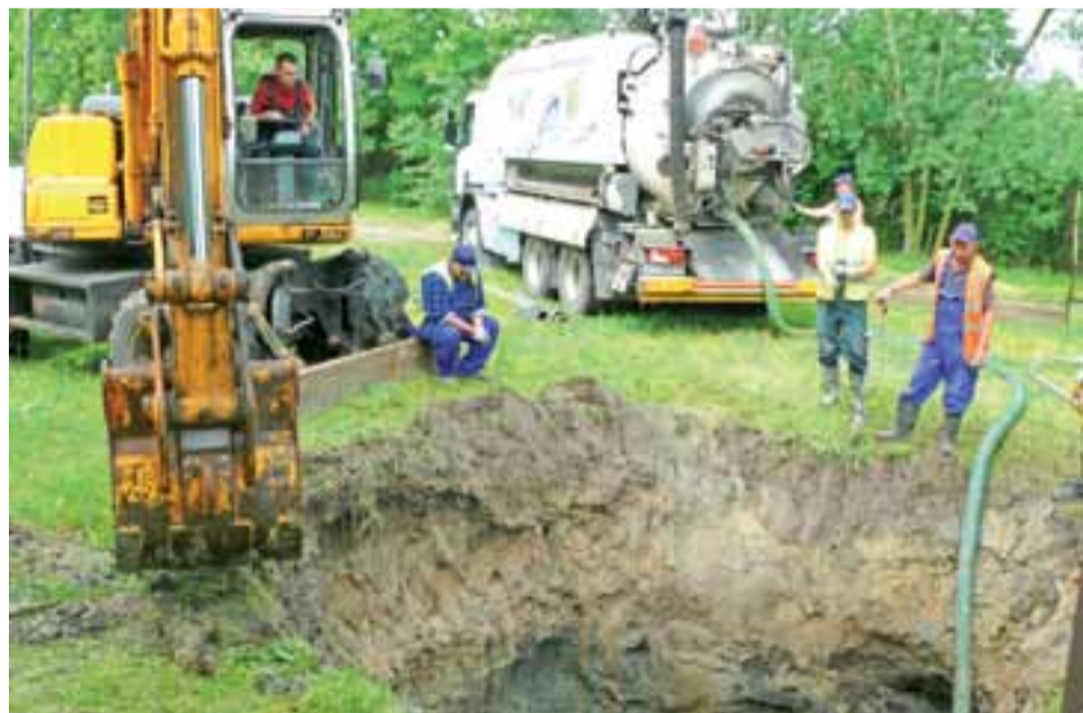
Pracownicy ZUK musieli wykopać głęboki na ok. 3 m dół, aby dostać się do pękniętej rury.
