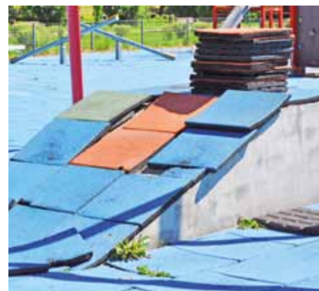
Poliuretanowe płyty nie trzymają się nawierzchni, więc dzieci często przenoszą je z miejsca na miejsce.
