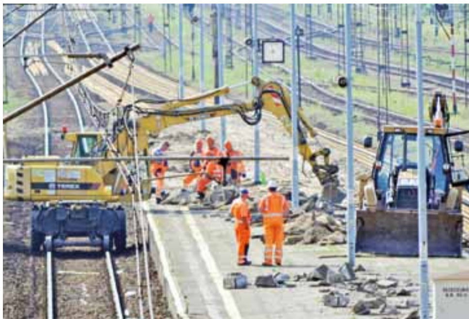
Prace rozbiórkowe na peronie nr 1 stacji Łowicz Główny. Dwa tory sąsiadujące z tym peronem zostały wyłączone z ruchu.
