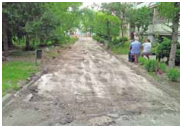
Sfrezowana nawierzchnia przed blokiem nr 9 na Bratkowicach.
