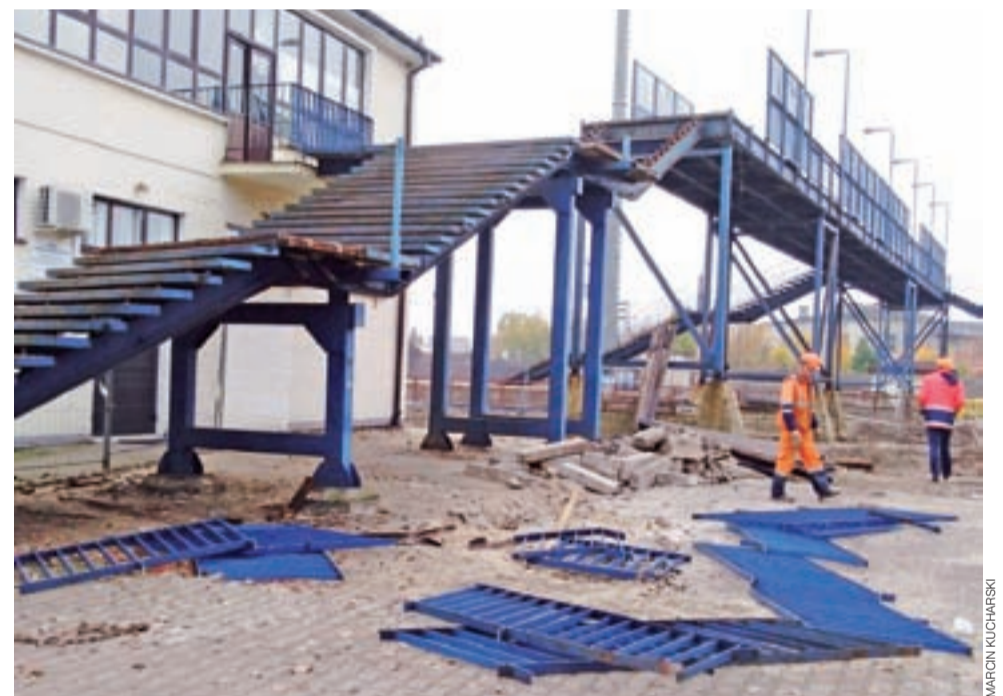
Najpierw demontowane były elementy kładki typu poręcze, osłony, a na końcu przyjdzie czas na konstrukcję.
