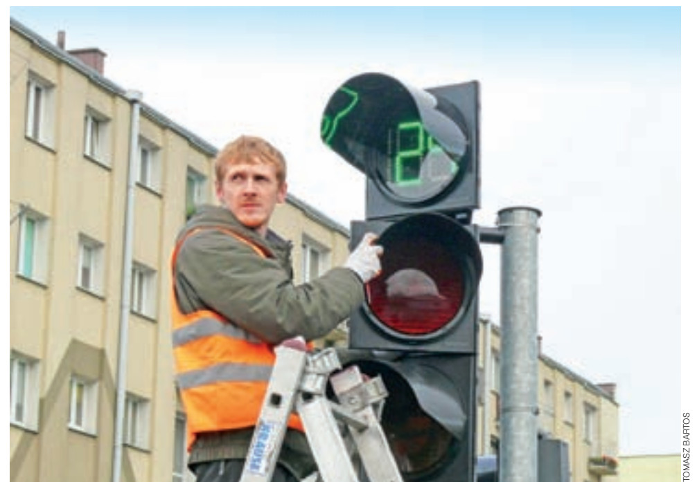
Bartłomiej Szczurek z firmy Swarco w czasie montowania sekundnika na skrzyżowaniu ulicy Sikorskiego z Broniewskiego i Piłsudskiego.
