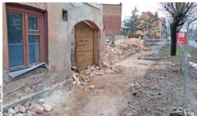
Parterowy budynek przy ul. 1 Maja został już całkowicie rozebrany.
