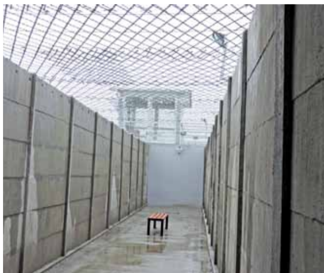
Nowy plac spacerowy na wyremontowanym oddziale.
