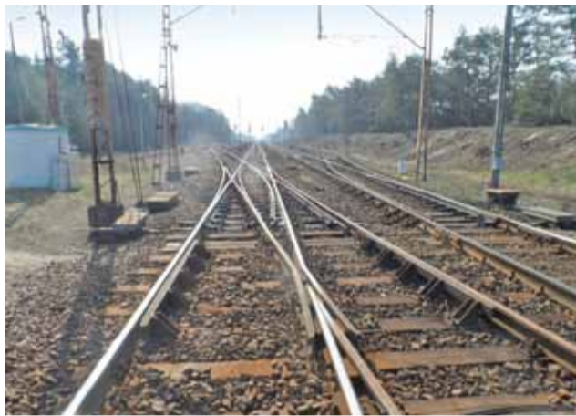
Stan torów na odcinku, który ma być modernizowany.
