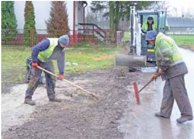
Trwa kładzenie kabla w ziemi w Rogóźnie.
