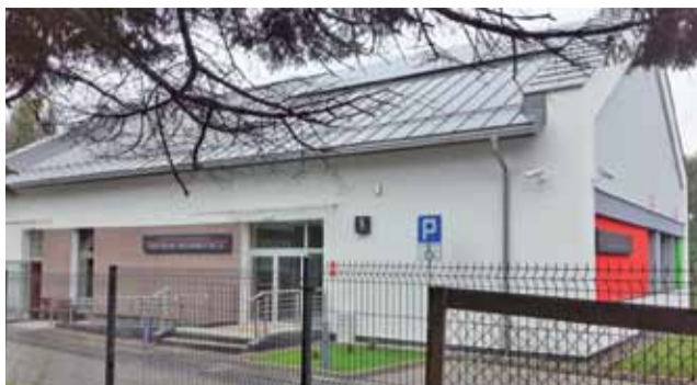
Budynek pasywny w Szczercowie pod Bełchatowem, który został oddany w tym roku. Mieści się w nim Centrum Rehabilitacji.
