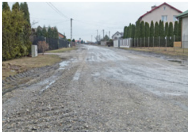
Stabilizowanie gruntu ma być przeprowadzone wiosną m.in. na ul. 11 Listopada.
