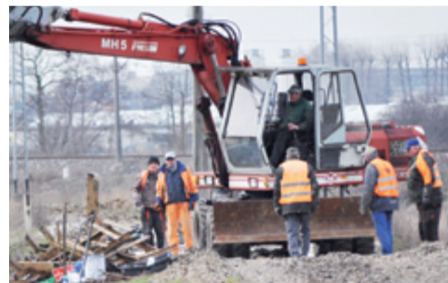
Roboty przy wymianie barierek na niedużym moście.
