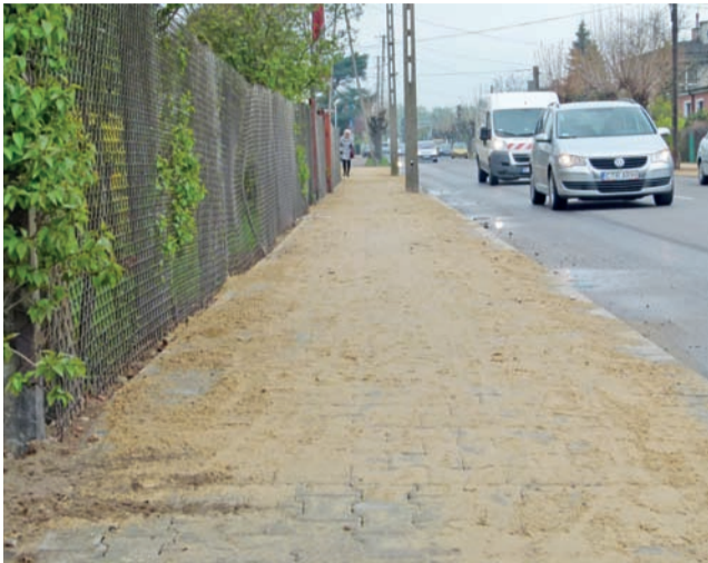
Mieszkańcy chwalą sposób wykonania chodnika przy Kopernika (tu odcinek od apteki do Spacerowej).
