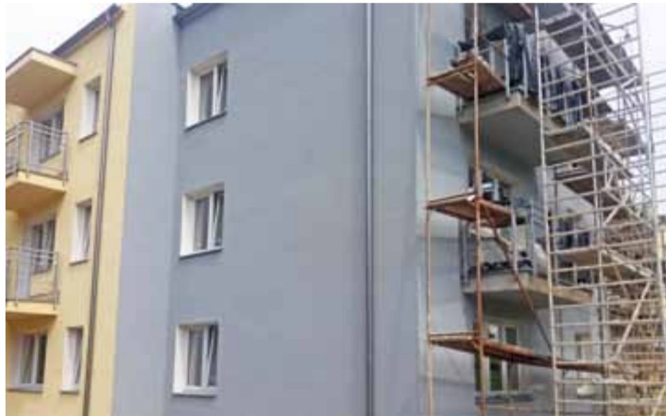
Już niedługo w tym bloku będą mogli zamieszkać pierwsi lokatorzy.
