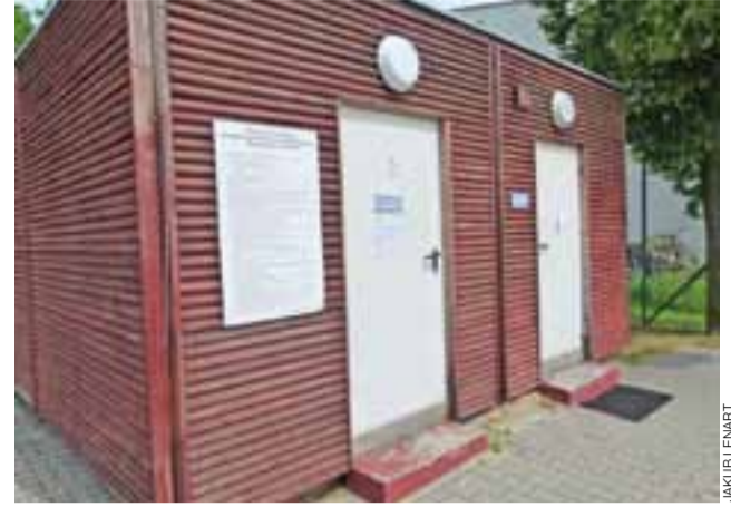
Baraki nabrały innego koloru dzięki impregnacji.
