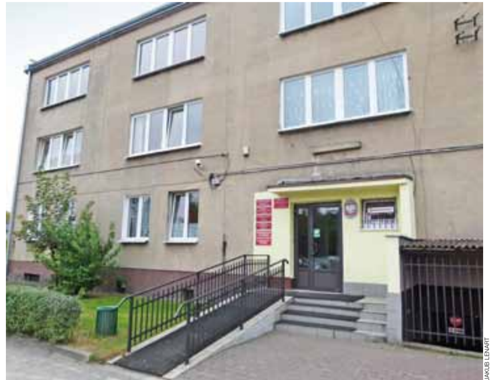
Zespół Szkół Specjalnych w Głownie. Budynek zostanie docieplony i pomalowany w ramach dużego zadania termomodernizacyjnego, obejmującego także wymianę źródeł ciepła.
