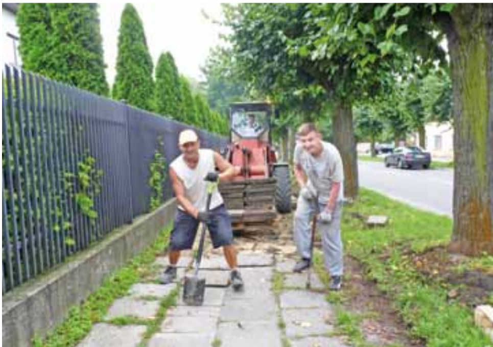
Pierwszy dzień budowy chodnika. 28 lipca ekipa wykonawcy inwestycji sprawnie demontowała stare płyty, które zastąpi kostka.
