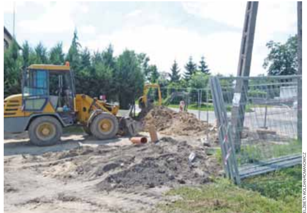
Prace na Nałkowskiej. Stan na 27 lipca.
