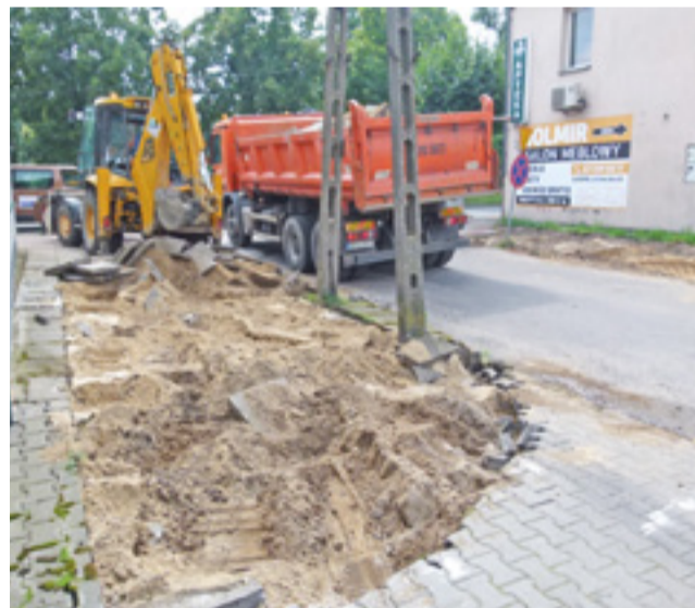
Trwa zrywanie starego chodnika przy rogu ul. Dworskiej i Łowickiej.
