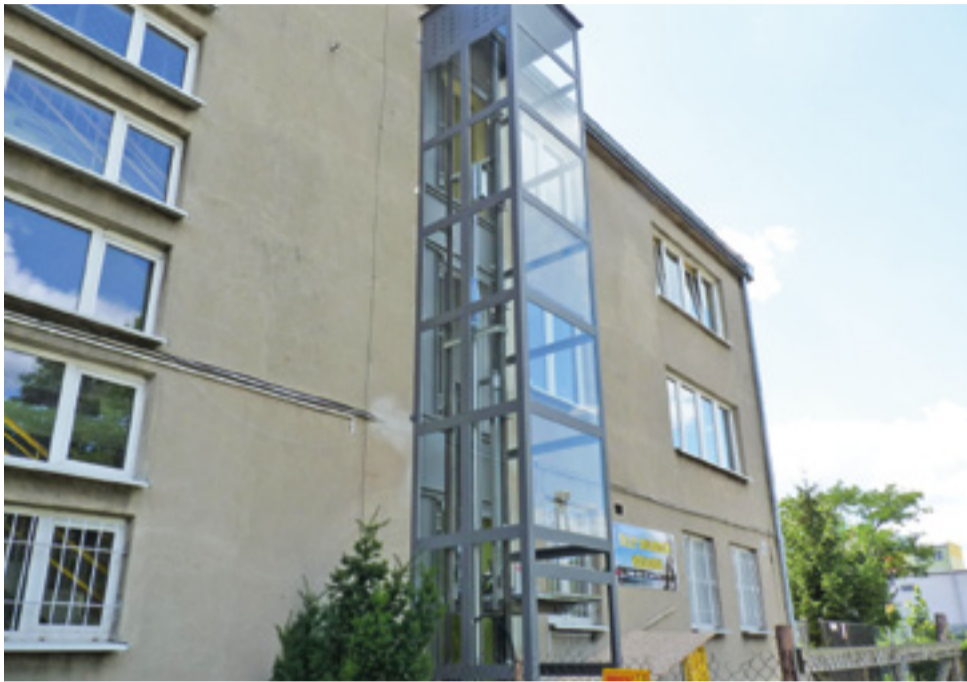
Przeszklony szyb windowy zamontowano na frontowej ścianie budynku ZSS.
