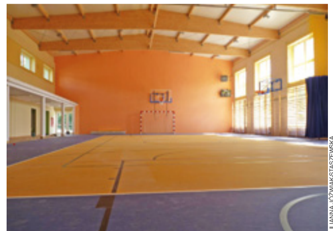
Nowa sala gimnastyczna już niemal wykończona. Brakuje jeszcze balustrady na antresoli.
