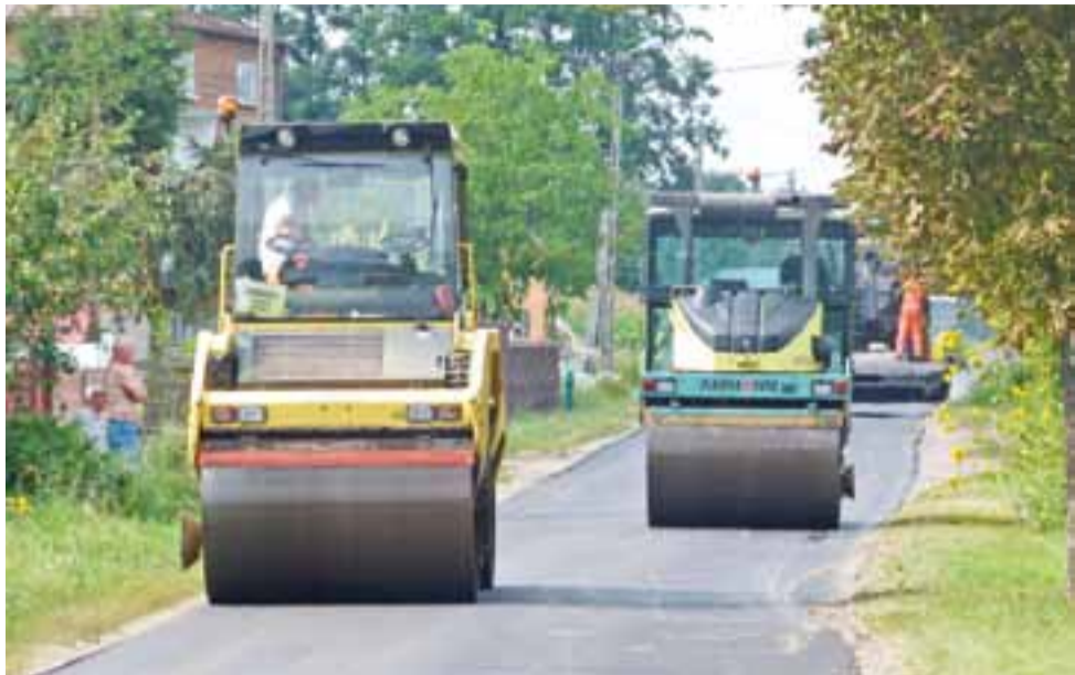
Walcowanie pierwszej warstwy asfaltu na drodze Mąkolice - Wola Mąkolska.
