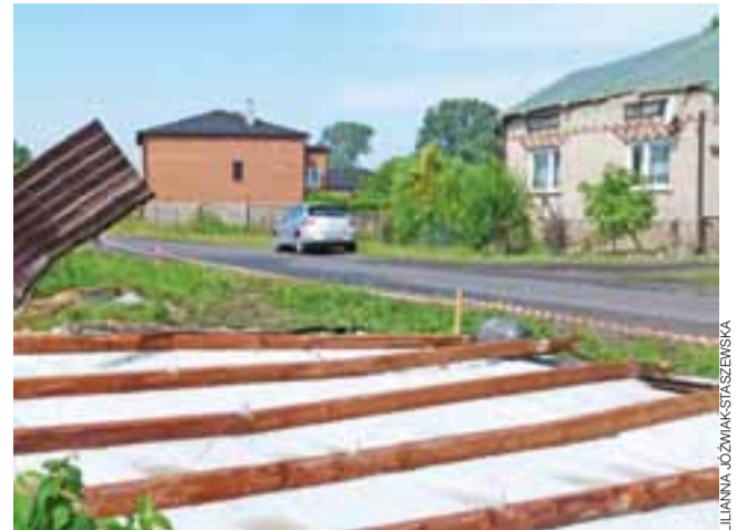
Część zerwanego w Szczecinie dachu, który zatarasował drogę, trzeba było ściągnąć na pobliskie pole.
