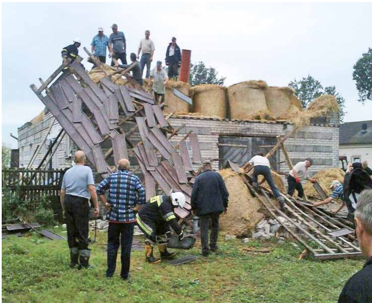
Prace nad rozbiórką pozostałości dachu na budynku inwentarsko-składowym w Wejskach.
