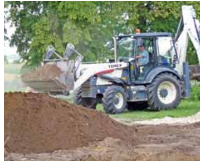
Trwają roboty przy utwardzeniu placu na zapleczu remizy w Koźlu.
