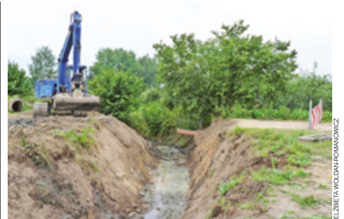
Przebudowa mostku w Lubiankowie. Stan prac na 17 sierpnia.
