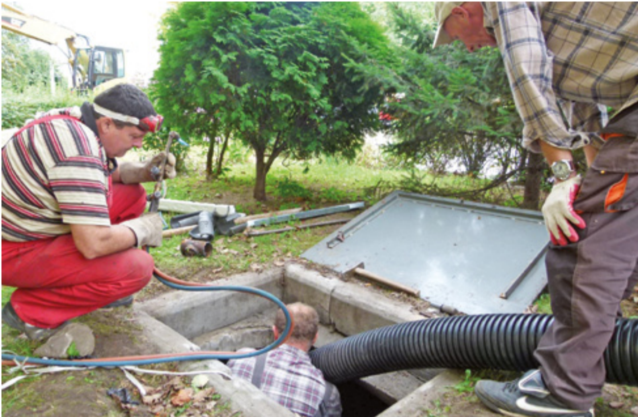
Firma instalacyjna Grzegorza Bartzaka ze Zgierza, z którą spółdzielnia podpisała umowę na wykonawstwo, ma poprowadzić nowe, preizolowane rury z kotłowni przy bloku nr 1 do bloków nr 2 i 3.
