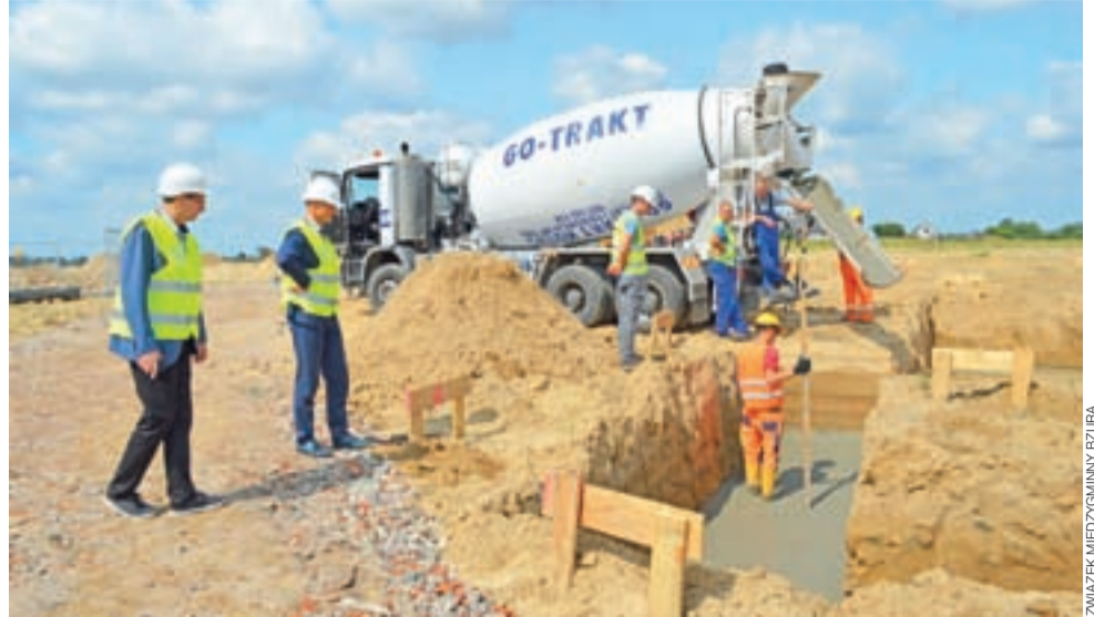
Inwestycja w Piaskach Bankowych rozpoczęła się w lipcu br. Zdjęcie wykonane zostało pod koniec sierpnia, gdy na placu budowy spotkali się członkowie Zarządu ZM Bzura z przedstawicielem wykonawcy i inspektorem nadzoru.
