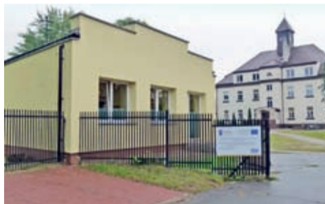
Budynek zwany „wagonem”, w którym mieści się prowizoryczna sala gimnastyczna w tym roku został poddany termomodernizacji z udziałem dotacji UE. W przyszłości miałby być wykorzystany na zaplecze klubu tenisowego, ale póki co szkoła musi główkować, jak upchnąć w nim wszystkie lekcje wf.
