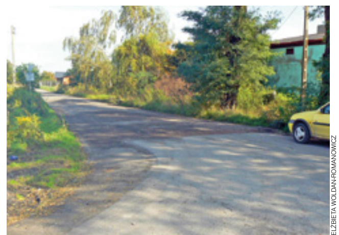
Ulica Wiejska w Głownie. Tutaj kończy się asfalt, dalej gruntowa już droga miejska biegnie w kierunku Konarzewa w gm. Głowno.
