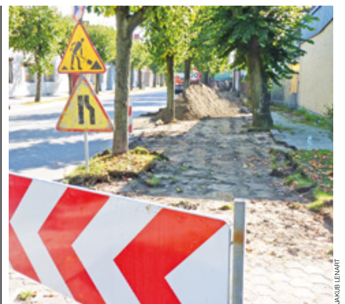
Rozpoczęły się prace przy budowie chodnika przy ul. Łowickiej.
