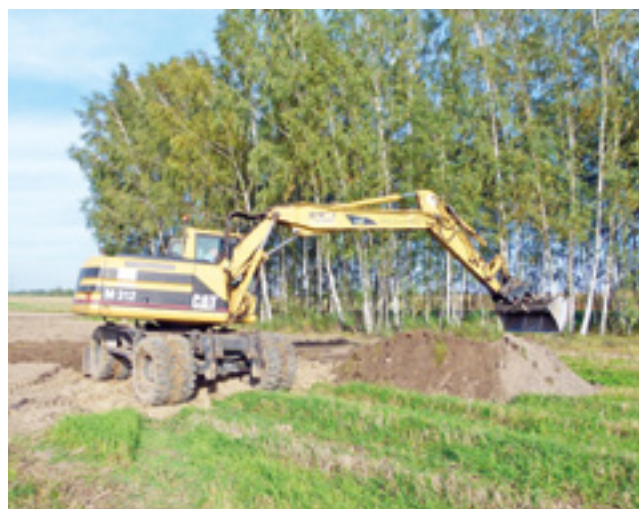
Prace ziemne przy budowie drogi dojazdowej do gruntów rolnych w Woli Błędowej.
