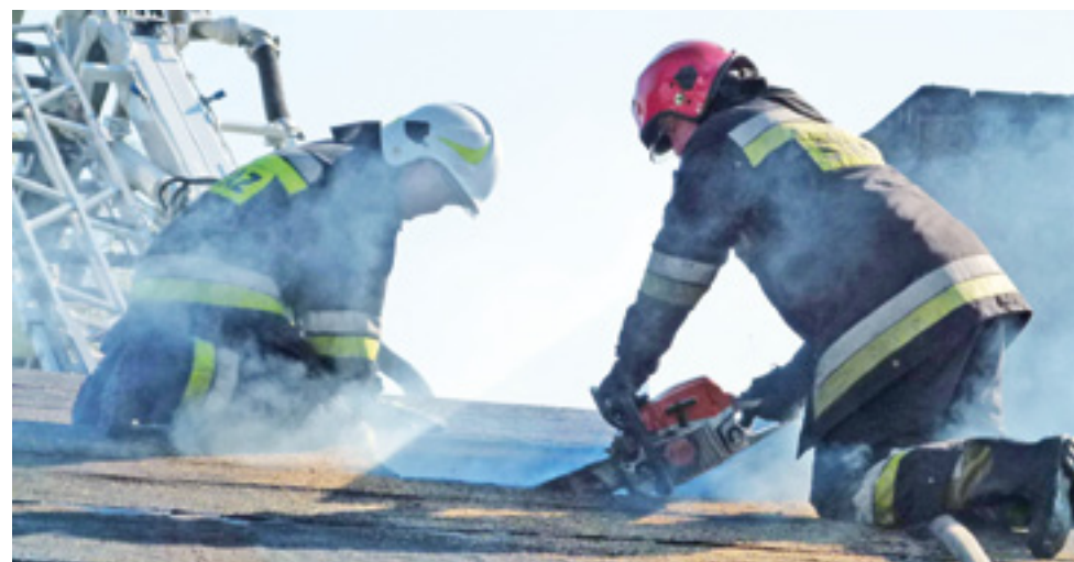
By skutecznie gasić pożar , strażacy musieli wykonać dostęp do palącego się poddasza budynku. W ruch poszła piła mechaniczna.
