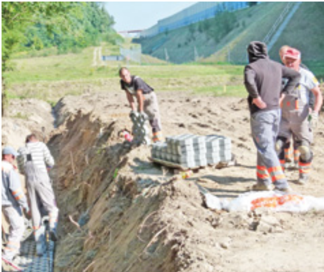
Budowa rowu odkrytego odprowadzającego wody w kierunku rzeki Mrogi.
