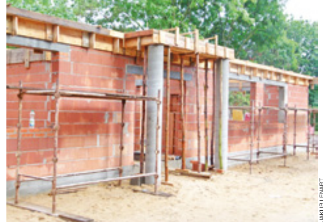
Coraz wyraźniej widać już kształt budynku, w którym mieścić będą się pracownie.
