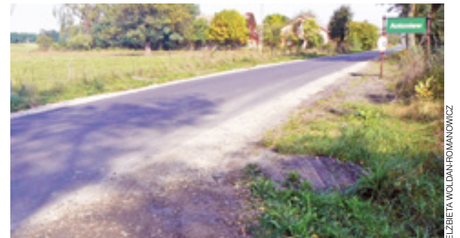
Droga w Antoniewie po odbiorze. Stan na piątek, 29 września, czyli po uzupełnieniu tłuczni na pobożnie.
