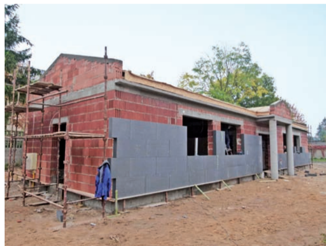
Budynek terapii zajęciowej. Po lewej stronie będzie znajdowała się kotłownia z osobnym wejściem, a z wejścia głównego będą korzystali uczestnicy. Stan na 20 października.
