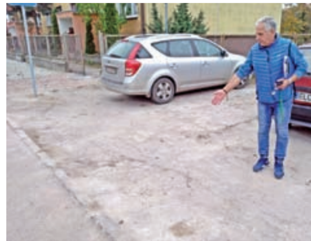
Wydział Inwestycji i Remontów ma rozważyć czy w tym miejscu też będzie ułożona betonowa kostka.
