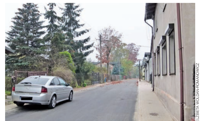
Ulica Limanowskiego w Głownie. Nowy asfalt i chodnik, stan na 20 października.
