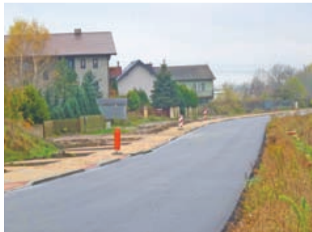
Rozległy rejon prowadzonej przez gminę inwestycji drogowej to nie tylko zabudowa mieszkalna, ale również niezagospodarowane tereny. Radny Bogdan Walczak nie wskazywał konkretnie do których właścicieli działek apeluje.
