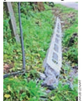
Strażacy zdemontowali słup, uznali, że tak będzie bezpieczniej.
