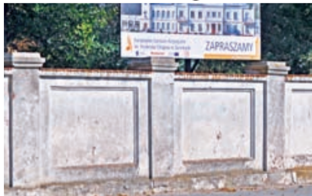
Ogrodzenie od strony ul. Warszawskiej ma zabytkowy charakter i będzie odrestaurowane.
