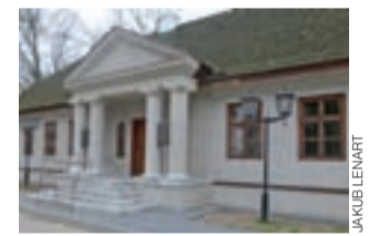
Po zakończeniu prac dworek będzie prezentował się z zewnątrz prawie jak nowy.
