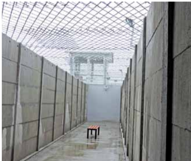
Nowy plac spacerowy na wyremontowanym oddziale.
