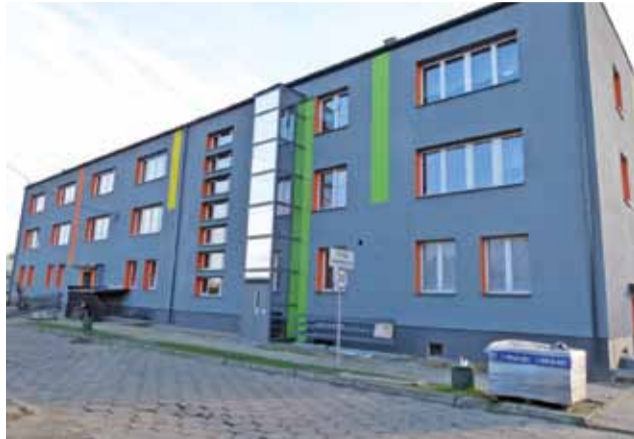
Zespół Szkół Specjalnych w Głowniu. Tak placówka wygląda po dociepleniu ścian i pomalowaniu elewacji. Stan na 12 grudnia.
