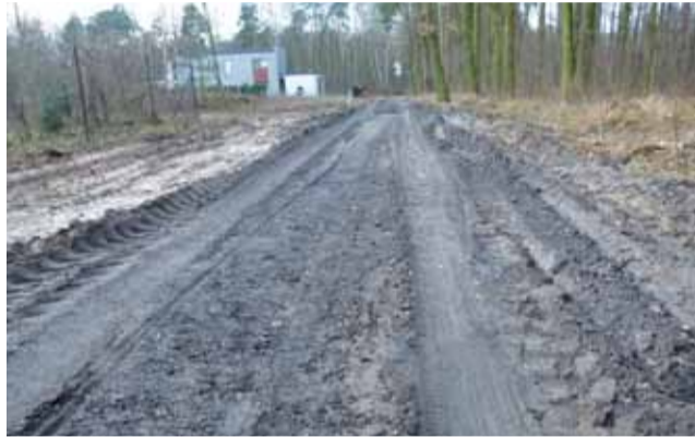
Odcinek ul. Świerkowej został wysypany żużlem.
