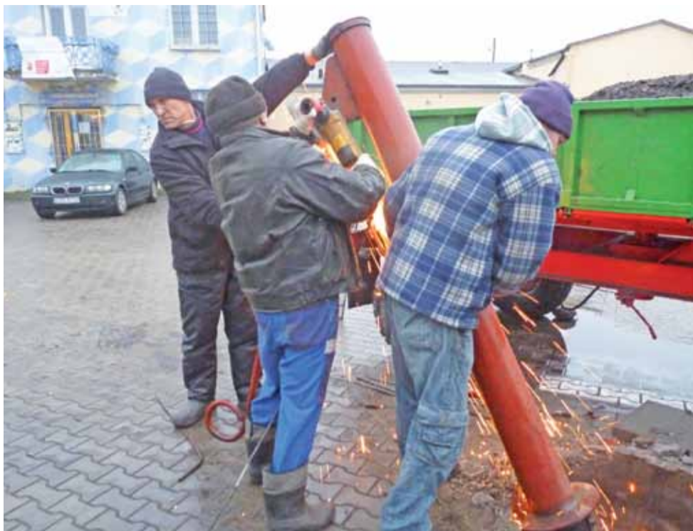
Demontażem pompy zajęła się Jednostka Robót Publicznych w Strykowie.
