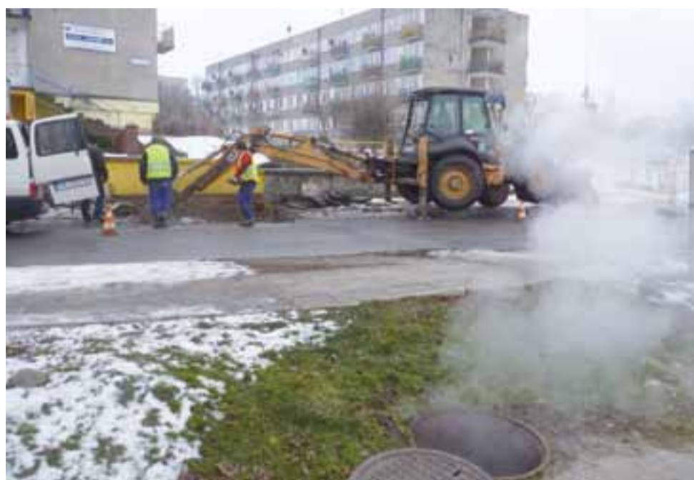
Awaria zaczęła się w niedzielę, około południa. Pracownicy ZEC musieli najpierw zerwać betonową płytę przykrywającą rury. Później konieczna okazała się wymiana rury.
