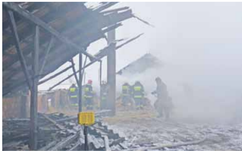
Ogień strawił cały dach, wraz z krokiewiami na budynku obory. Akcję ratowniczą utrudniało duże zadymienie, pomimo stosowania oddymiaczy. Dobrze, że ogień nie przeszedł przez betonowy strop.
