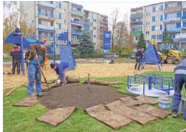
5 listopada zakończono budowę boiska Nivea na osiedlu Traugutta. Boisko zostanie jednak udostępnione dopiero na wiosnę, w tym czasie trawa ma się dobrze ukorzenić.
