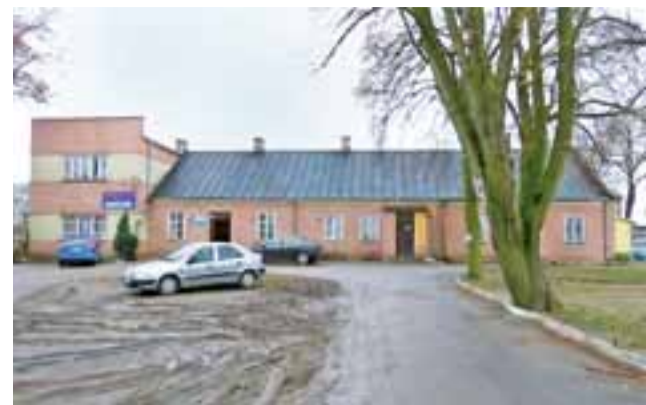
W ramach rewitalizacji centrum Zdun wyburzony będzie widoczny w tle parterowy budynek. Pomiędzy Urzędem Gminy a Domem Kultury powstaną parkingi, nowe ścieżki i zieleń.
