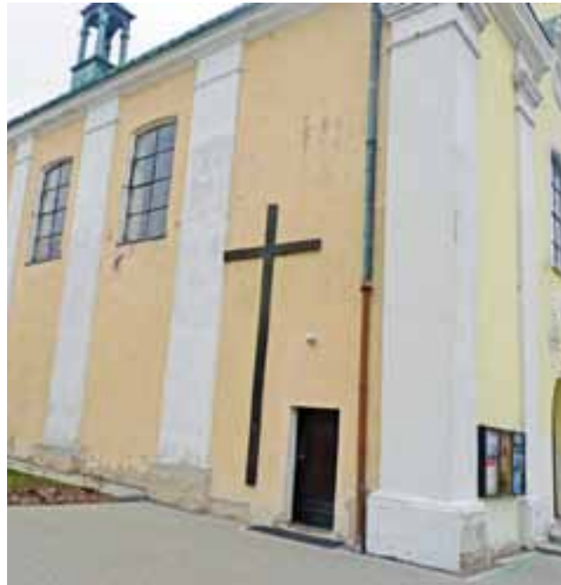
W wielu miejscach tynk na zabytkowym kościele w Żychlinie odpada. Remont elewacji jest coraz bardziej potrzebny.
