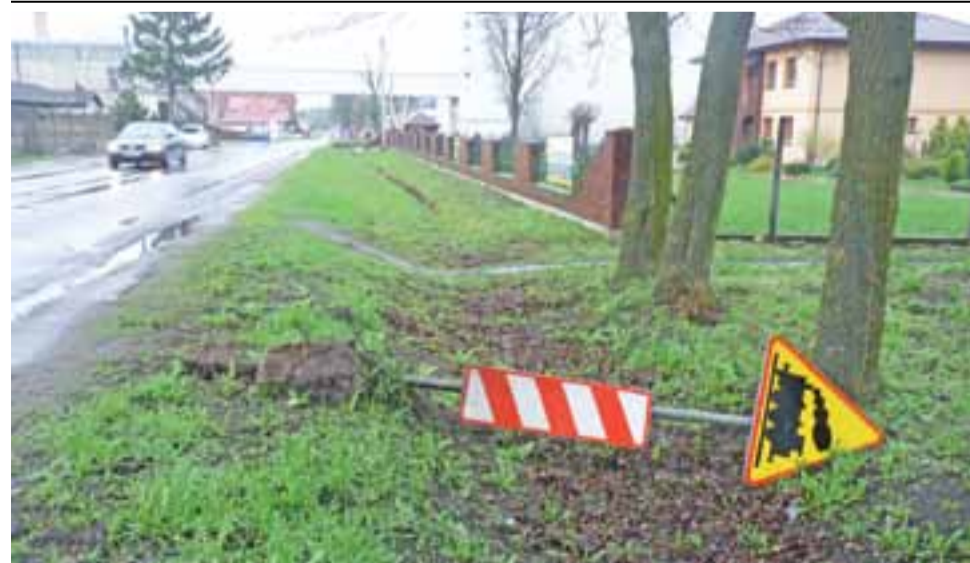
Nawet 30-centymetrowe betonowe wzmocnienie nie przeszkodziło w przewróceniu znaku ostrzegawczego przed przejazdem kolejowym w Dobrzelinie. Znak został najwyraźniej potrącony przez ciężki samochód. Kierowcy teraz muszą szukać ostrzeżenia w rowie. dag
