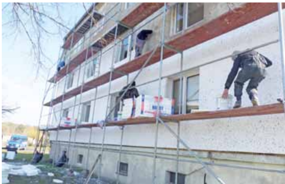
W połowie marca rozpoczęto docieplanie trzeciej ściany bloku nr 22 w Luszyń. Prace już zakończono.
