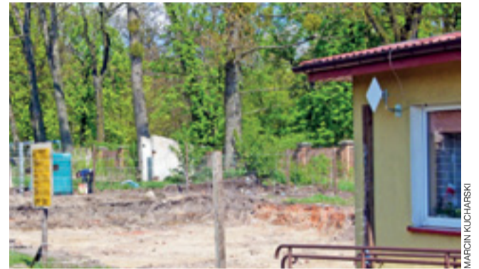
Budowa bloku socjalnego przy Fabrycznej dopiero się rozpoczęła.
