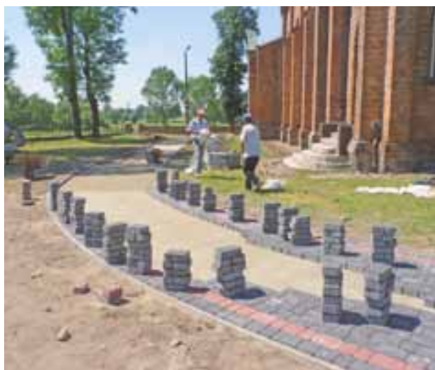
Rozpoczęto prace przy drugim etapie budowy chodnika wokół kościoła w Pacynie. Prace wykonuje firma DalBud z Janówka.
