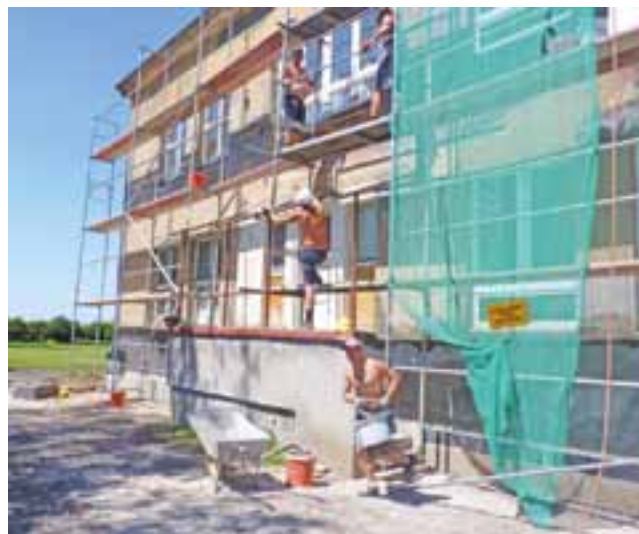
Firma Elbud przystąpiła do termomodernizacji budynku po dawnej szkole w Skrzyszewach. Docieplili fundamenty, teraz docieplają ściany.
