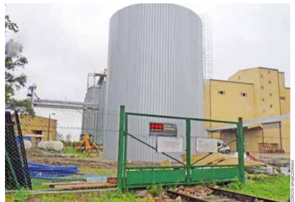
Cargill w Dobrzelinie inwestuje. Już wybudowano zbiornik ppoż. o pojemności 600 m 3 , rozpoczęto budowę nowej suszarni kukurydzy, zasilanej gazem LPG. Zbiorniki na paliwo już stoją.
