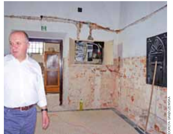
Ojciec Czesław Matras nadzoruje roboty budowlane prowadzone w kościele. Przy okazji skuwania tynków robiona jest nowa instalacja elektryczna.
