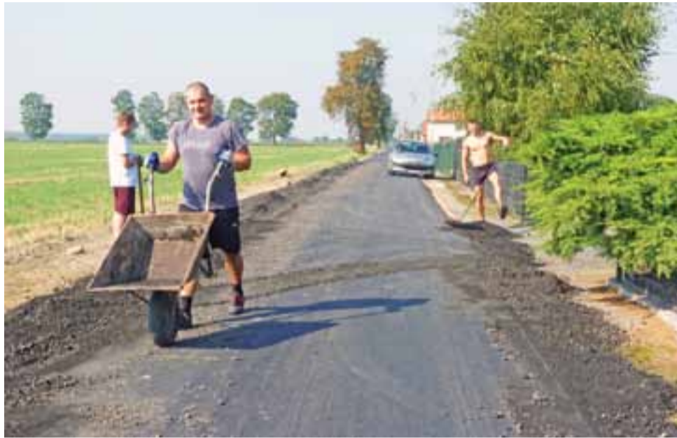
Mieszkańcy Jaworzyny sami pomagali w rozsypaniu szlaki na poboczach nowej nawierzchni asfaltowej.
