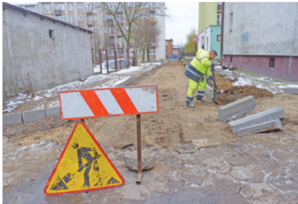
Trwa modernizacja 135 m drogi wewnętrznej od ulicy Hanki Sawickiej do Dąbrowskiego. Droga zostanie wyłożona kostką polbrukową.
