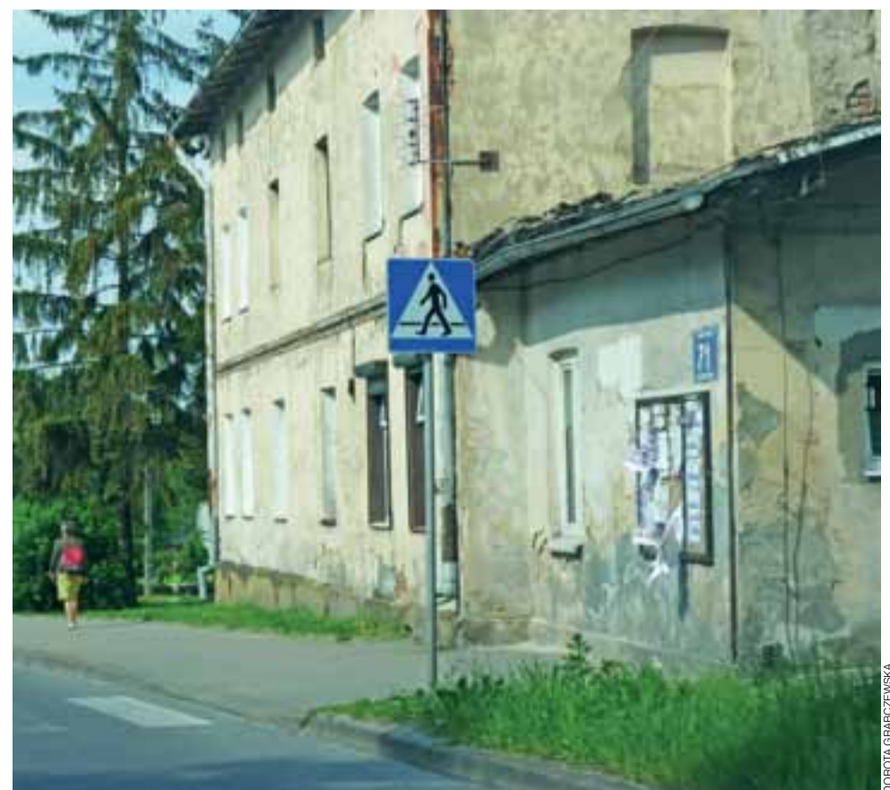
Budynek przy ulicy Narutowicza 71 doczeka się remontu elewacji.
