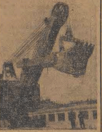
Olbrzymia kopaczka mechaniczna produkcji radzieckiej
