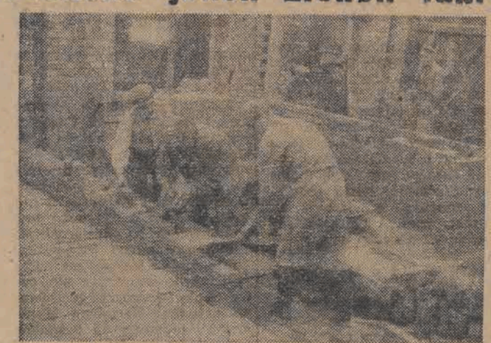
Kobiety z Państwowych Zakładów Przemysłu Dzielniarskiego im. Ofiar 10 września czekają z niecierpliwością na budujący się żłobek dla dzieci. Czekają już dłużej — miał być gotowy latem roku bieżącego, ale przy wykopach natrafiono na wodę, którą trzeba było wypompować. Ta nieprzewidziana przeszkoda opóźniła budowę. Obecny plan prac przewiduje jej ukończenie na 15 listopada br.
