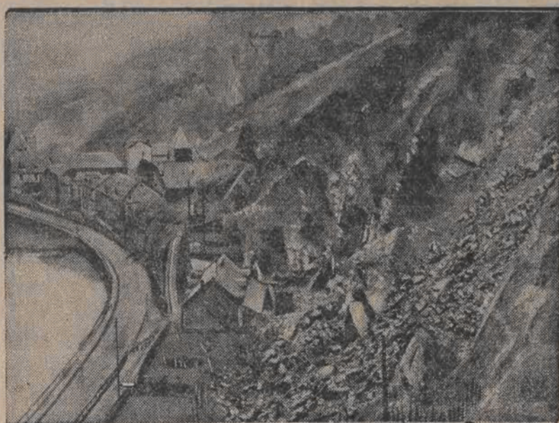
Hier stürzten die Felsmassen in die Tiefe.
