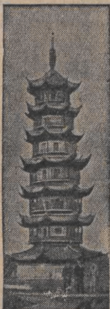
Ein vom Krieg bedrohter Bau: Stadterpagode der Drachenschönheit bei Schanghai. Aus dem Großen Brockhaus. Mit Genehmigung des Verlages.
