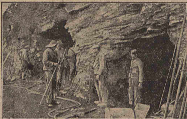
Vom Bau der deutschen Zugspitzbahn. Ausbruchstollen der Tunnelstrecke in 1900 m Höhe
