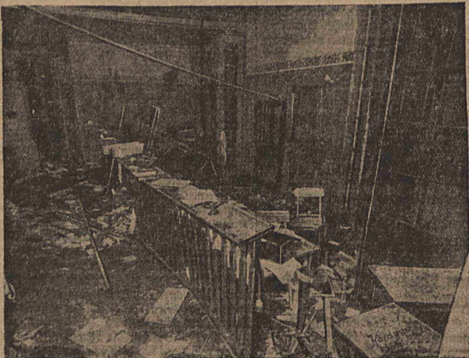
Das Bureau der Messedirektion nach der Explosion der Pulvermaschine.
