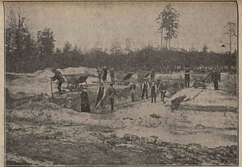
Planierungsarbeiten im neuen Volkspark an der Konstanzener Chaussee
