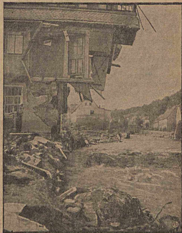
Ein bei der Unwetterkatastrophe in Berggießhübel im Erzgebirge zerrissenes Haus.
