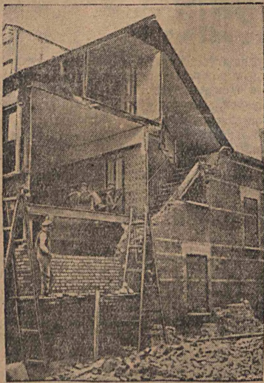
Ein Haus in London, dessen Giebelwand durch den Sturm umstürzte. Zwei Personen wurden durch die niederfallenden Trümmer getötet.
