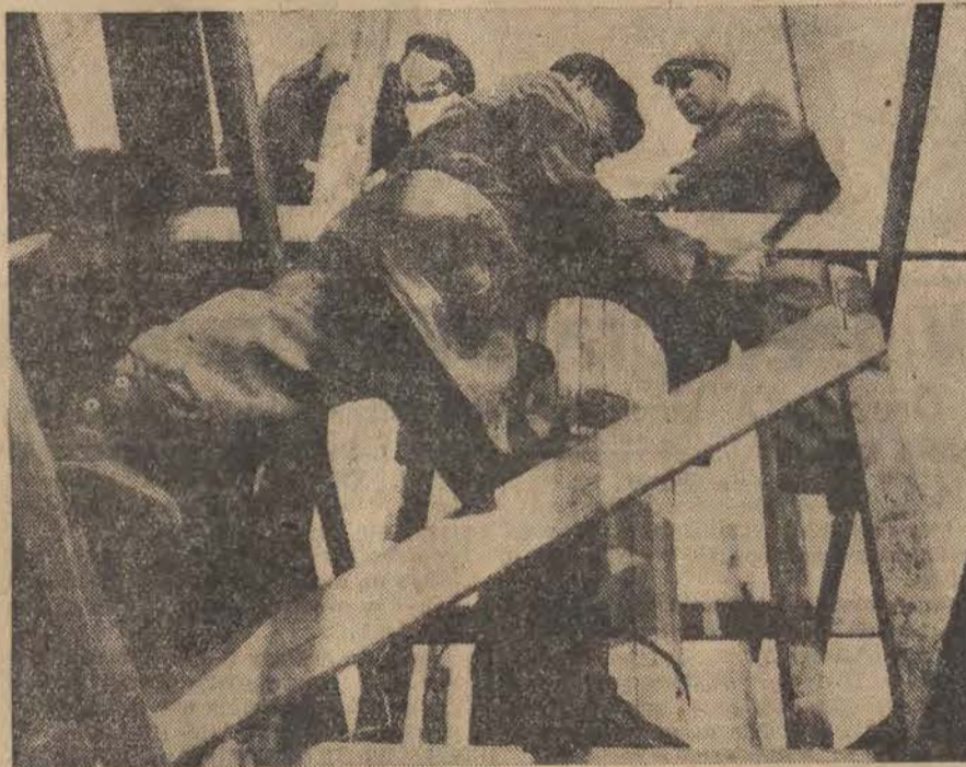
Odłogi młotków mieszają się ze zgrzytem pił. Ładna pogoda sprzyja robotom budowlanym.
