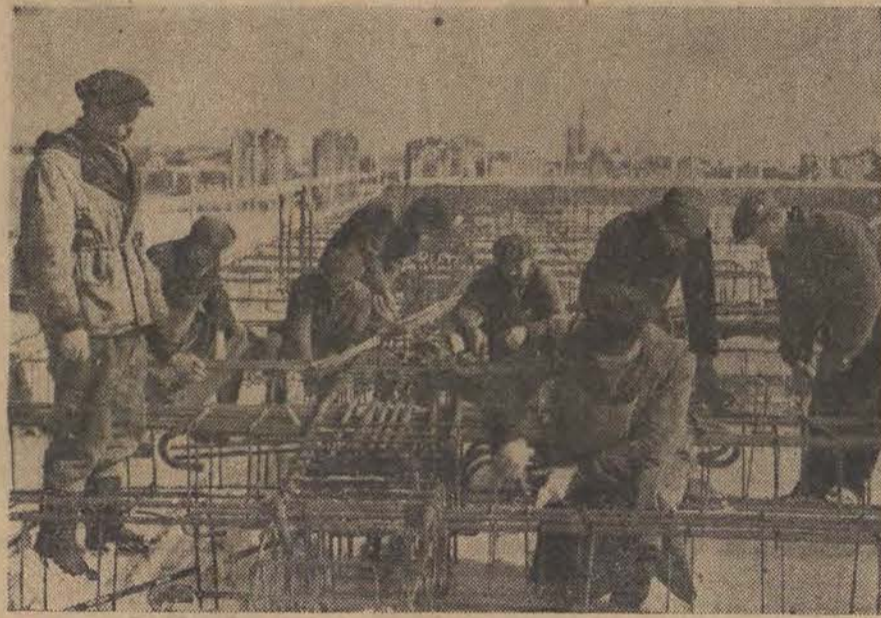
Współzawodnictwo o tytuł najlepszego zespołu budowlanego w Polsce — rozwija się. Przystępują do niego stale nowe zespoły. Na zdjęciu najlepsza grupa zbrojarzy PPB Nr 1 w Warszawie, pracująca przy budowie gmachu Urzędu Statystycznego.
