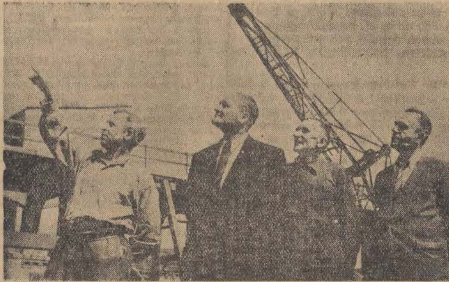
Dyrektor gazowni łódzkiej (drugi z lewej), były robotnik tejże gazowni — Aleksander Baran przed nowowyremontowanym generatorem.
