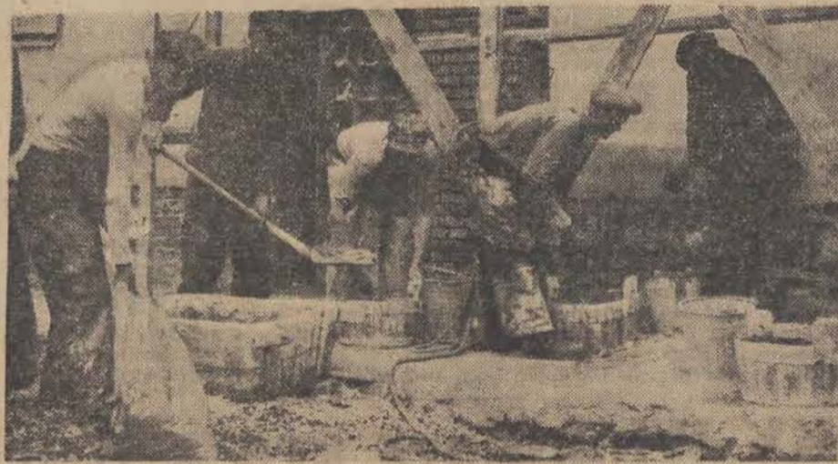
Zespół tynkarski Jana Godziszewskiego, pracujący przy budowie osiedla mokotowskiego w Warszawie osiąga 130 procent nowej normy.
