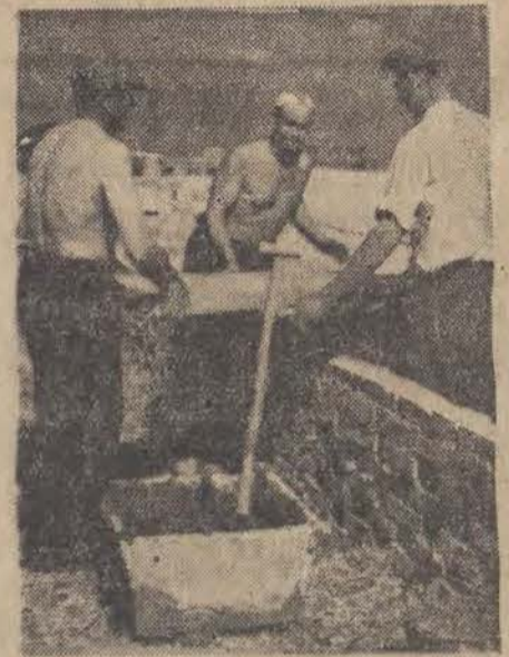
Dachy bloków mieszkalnych w osiedlu mieszkaniowym Muranów w Warszawie układane są z prefabrykowanych betonowych płyt. Na zdjęciu — betoniarze z brygady Szangary przy pracy na bloku nr 113. Foto AR
