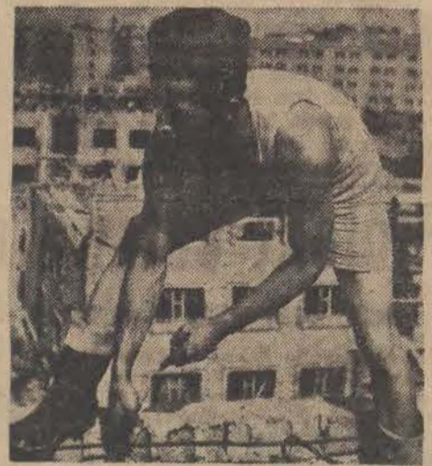
Budowa osiedla mieszkaniowego Muranów w Warszawie: na pierwszym planie zbrojarz z brygady młodzieżowej, Leon Rowiński.
